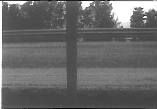
Fotografía N°42 (25.03.2015) Descenso de 2 cm, berma, km 27, sentido oriente.
