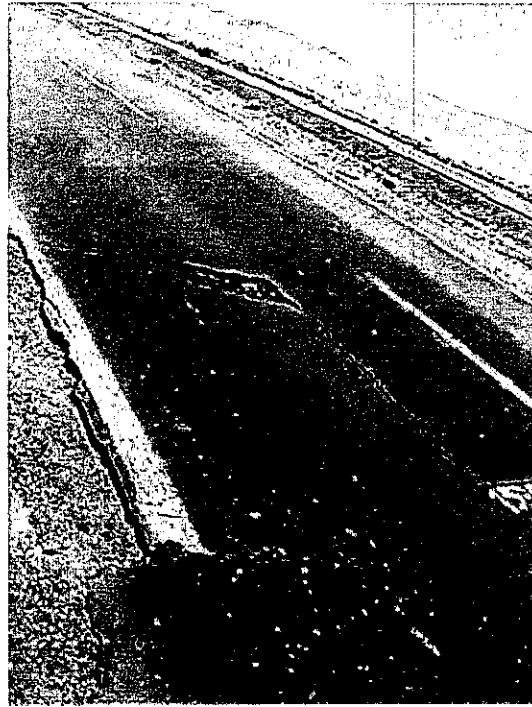
Fotografía N° 5. Bache en km 1.447,5 de la Ruta 5
