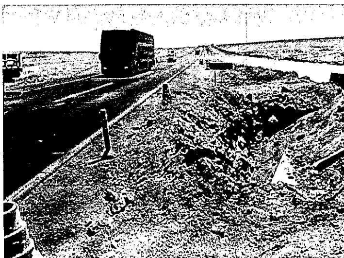
Fotografía N°11. Trabajos en la berma km 1.452.6, Ruta 5
