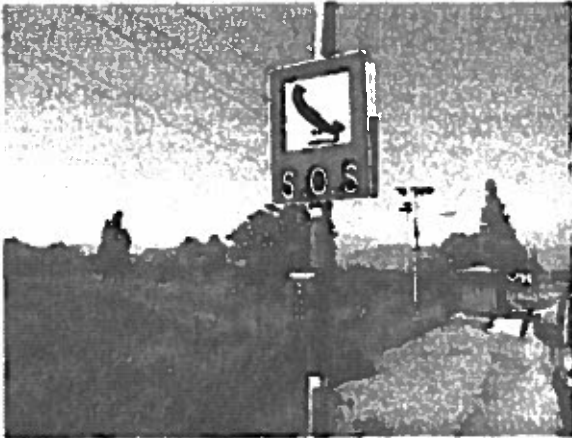
Fotografía N° 3: Teléfono S.O.S. sin identificación de posición.
