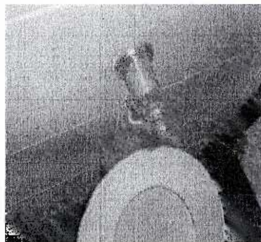
Fotos N os 20 - 21: Cielo desprendido y filtración en llave de wc.
