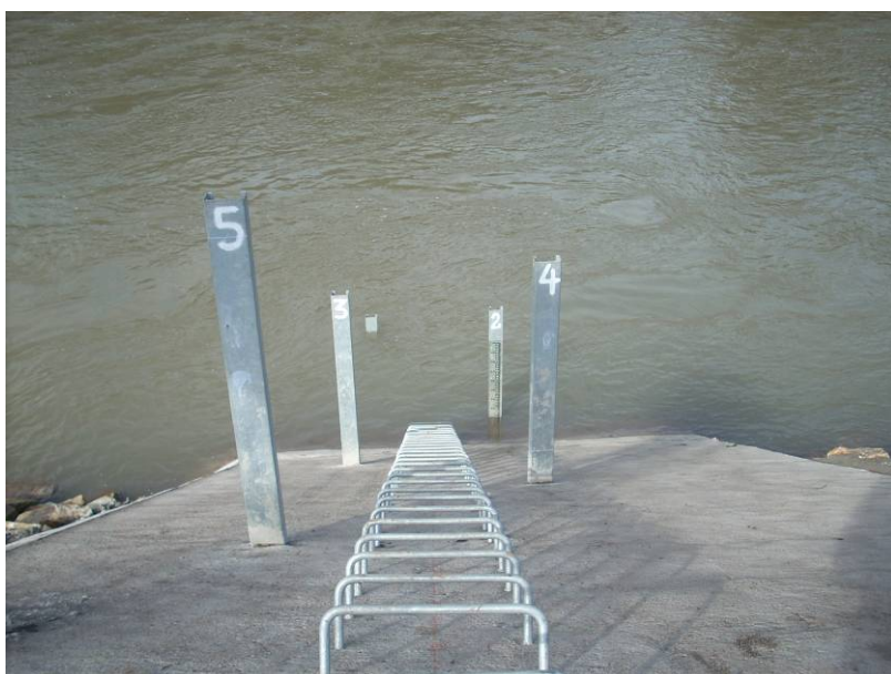
Foto 3 Regla limnimetrica desprendida en el costado de la presa auxiliar
