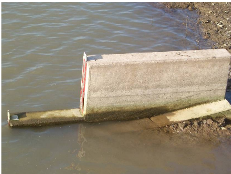
Foto 3 Regla limnimetrica desprendida en el costado de la presa auxiliar
