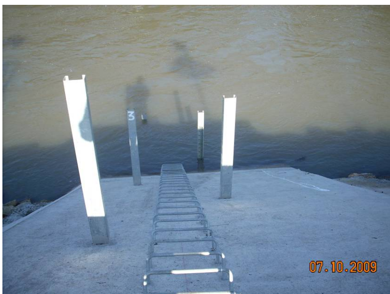
Fotos 4 y 5 Falta de reglas limnimetricas en estación de medición Lo Toro, días 2 y 10 de julio.
