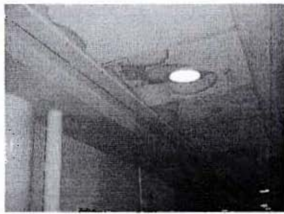
Fotos 3 y 4. Palmetas deterioradas en cielo falso, área de servicios (nivel +0,00).
