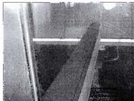
Fotos 17 y 18. Acumulación de polvo en vigas de hormigón situada sobre sector de aduanas.
